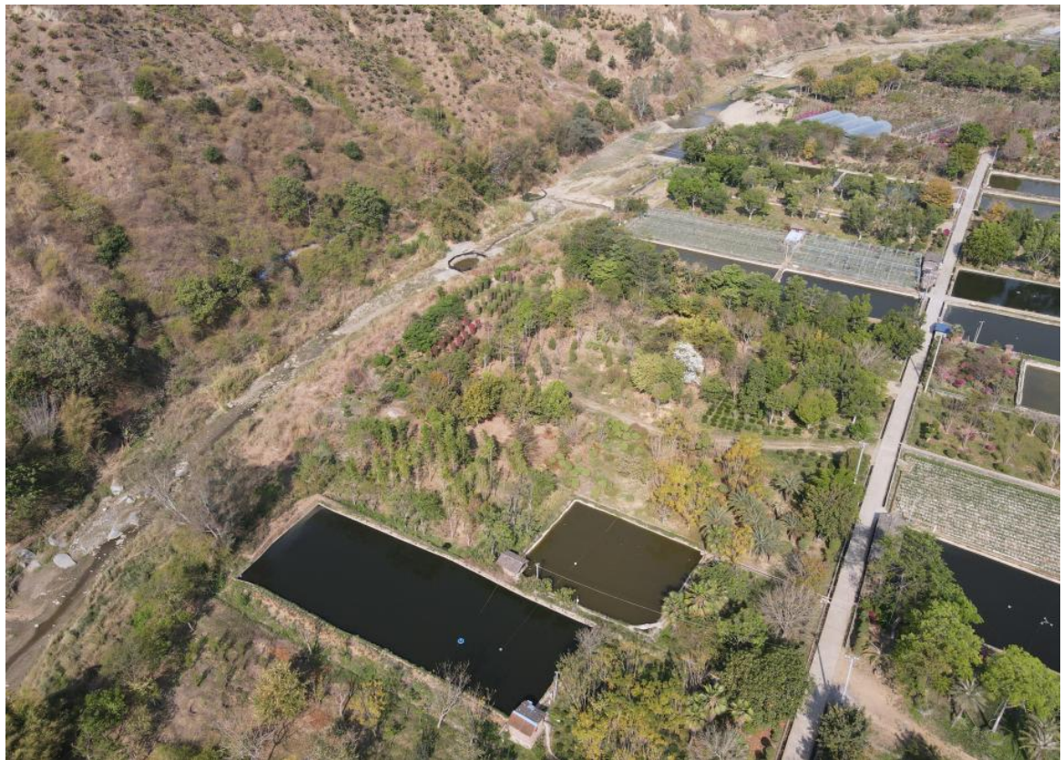
图 3-6 火烧桥段表土及回填土临时堆场、淤泥中转场拟建地址现状照片
