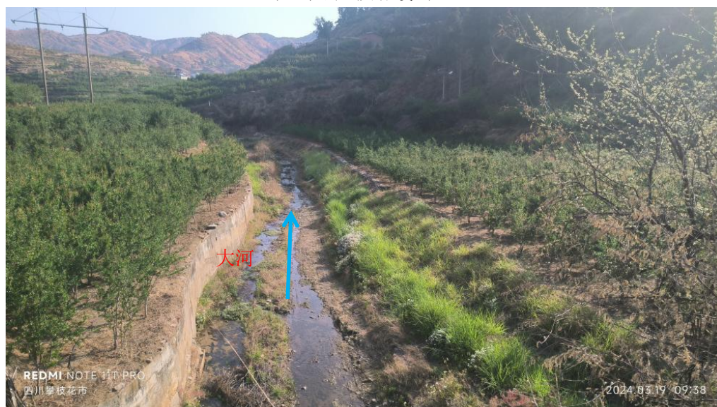
大河银鹿段河道（银右一堤防段，河道左侧为堤防加固段）
