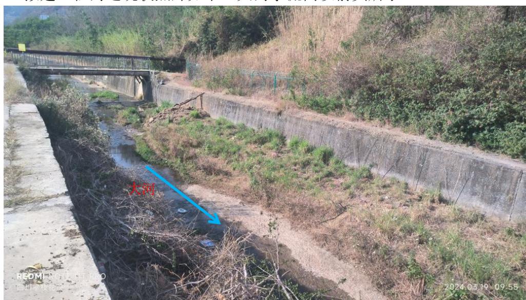
大河银鹿段疏浚河道
