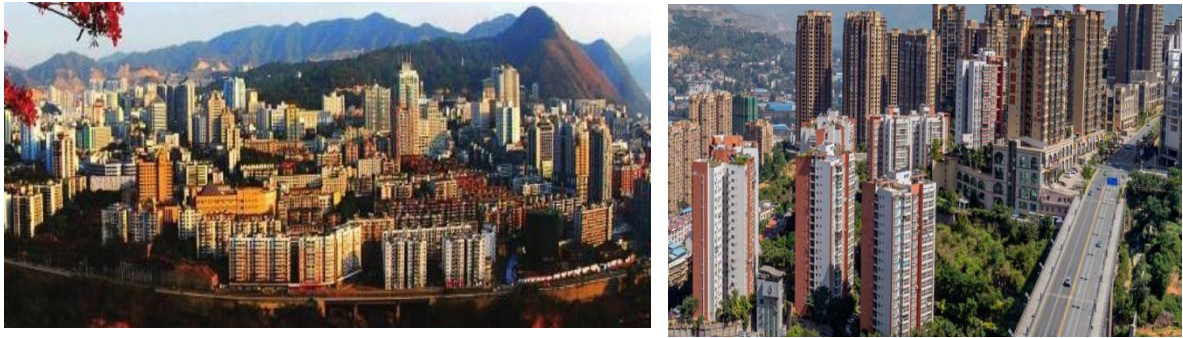
图 2 攀枝花市框剪结构建筑物
