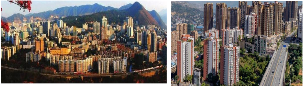
图 2 攀枝花市框剪结构建筑物
