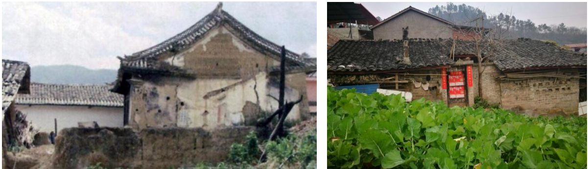
图 4 攀枝花市砖木结构建筑物
